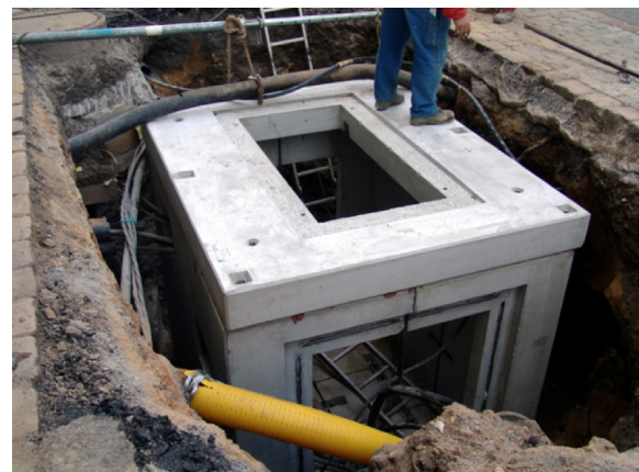
Die Deckenplatte vorschriftsmäßig anschlagen, passgenau über die Stahldollen führen und auf dem Schacht absetzen und ausrichten.
