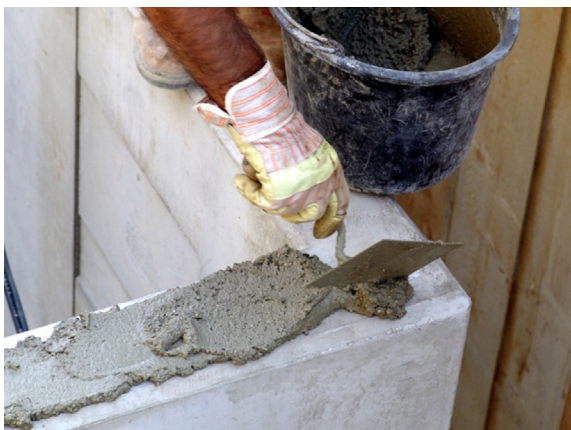
Die Lagerfläche säubern und ein Mörtelbett herstellen.
