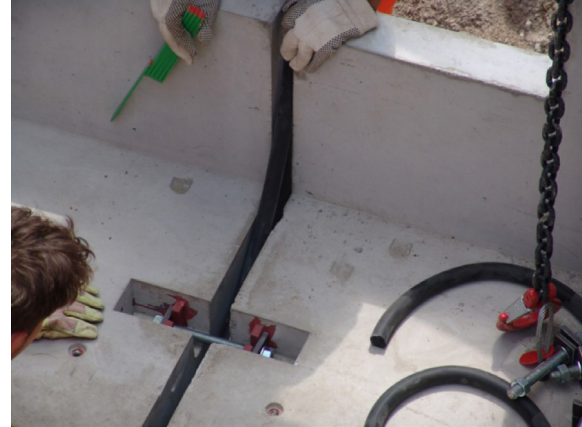
Schachtelemente mit Schraubensätzen verbinden
