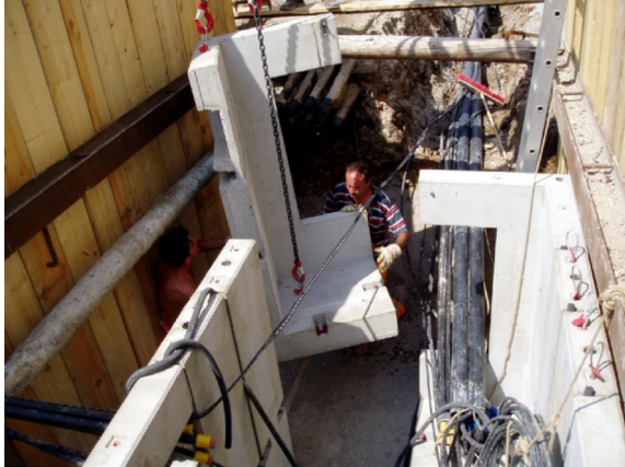
Montage Eckelement (bessere Justierung durch Anschlagen an drei Punkten)
