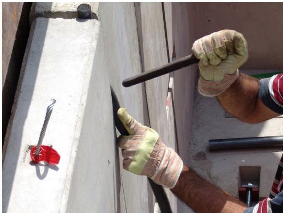
Querfugen mit Dichtgummis abdichten
